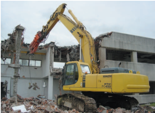
FIGURA 4.- DENTRO DE LOS SERVICIOS INTEGRALES QUE OFRECE VD, VOLADURAS Y DEMOLICIONES, SE ENCUENTRAN LA REDUCCIÓN Y CLASIFICACIÓN DE RCD.
