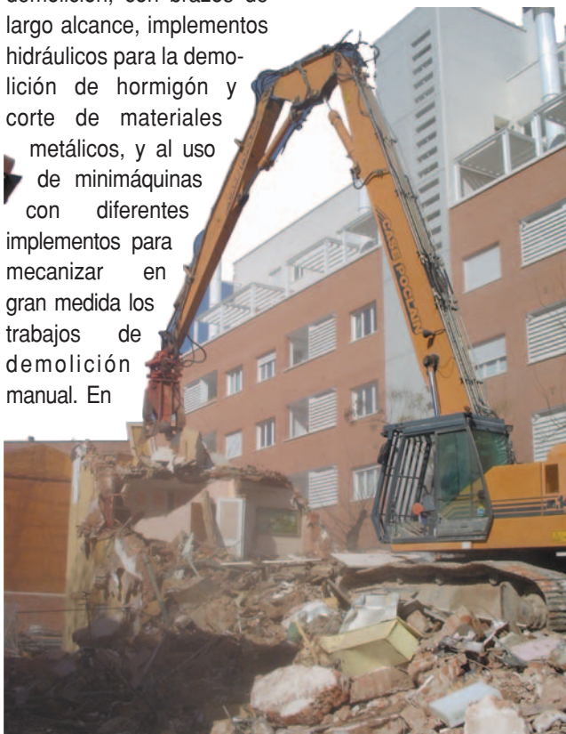
FIGURA 1.- VD, VOLADURAS Y DEMOLICIONES, CUENTA CON EXCAVADORAS PARA LAS DEMOLICIONES A GRAN ALTURA.
